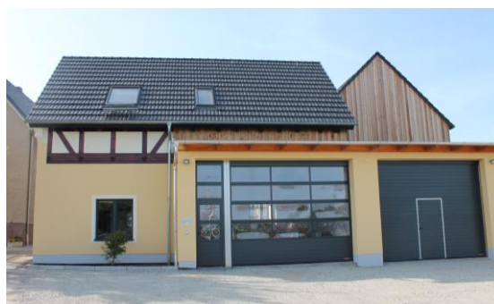
Gebäude nach der Sanierung
