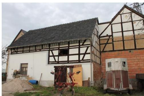
Gebäude vor der Sanierung
