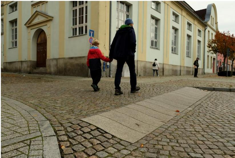
Aufpflasterungen zur Sichtbarmachung der Vorrangregelung an Einmündungen
