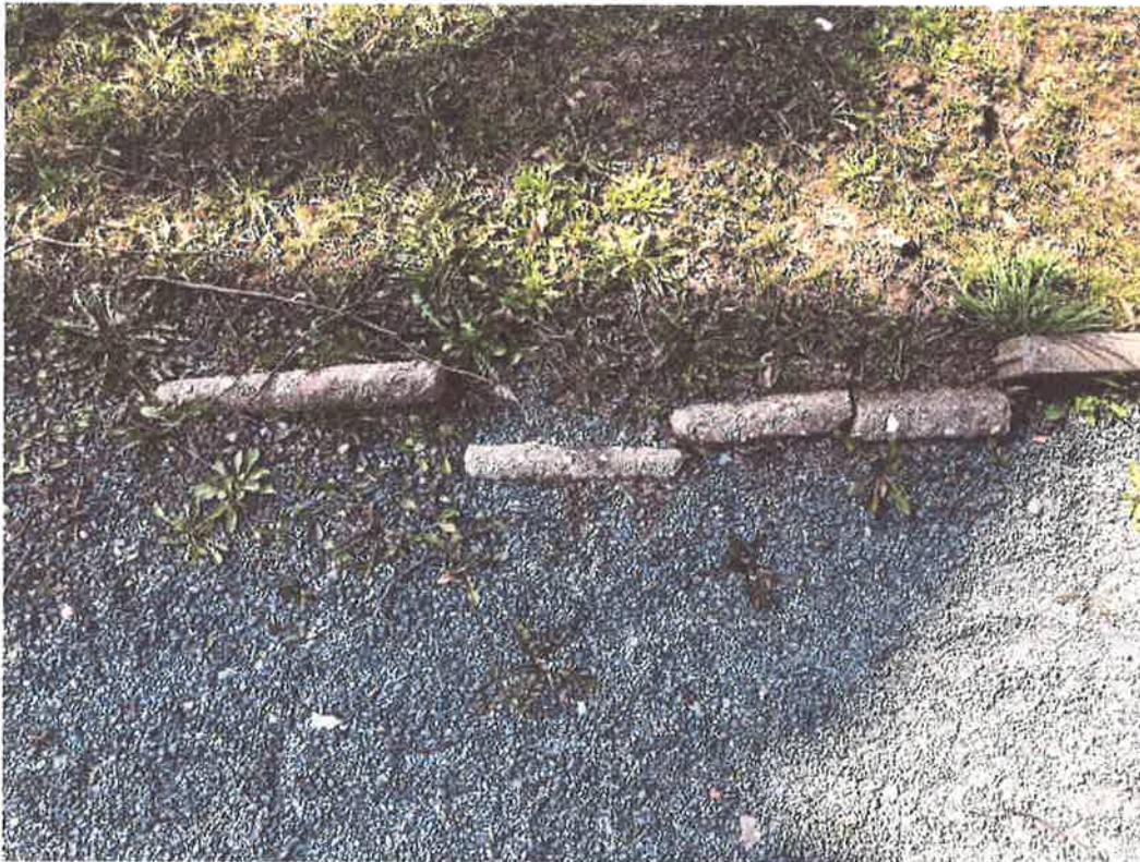
Zustand des Wegenetzes
