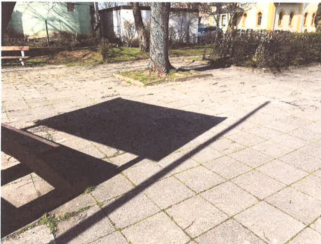
Zustand befestigte Fläche
